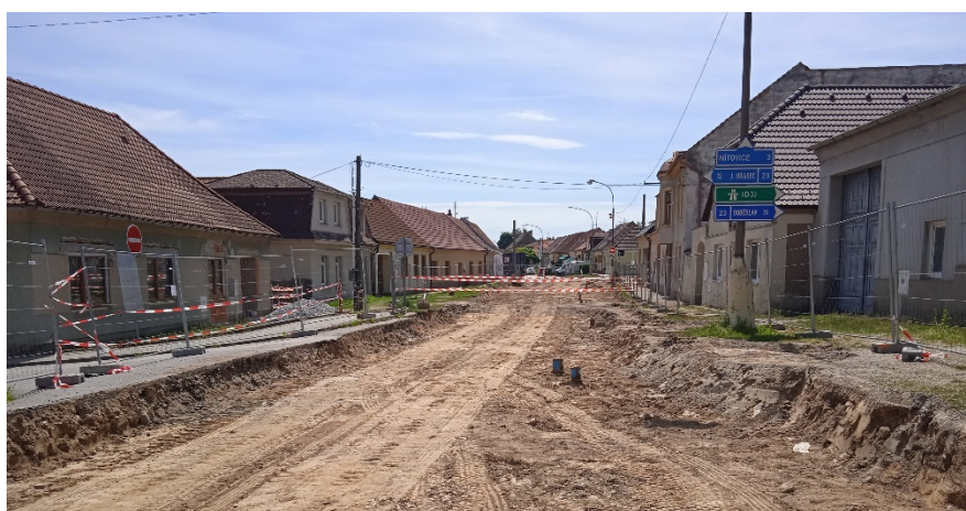
Zateplení bytového domu č.p. 704 a rekonstrukce ulice Tyršova. (archiv Města)
