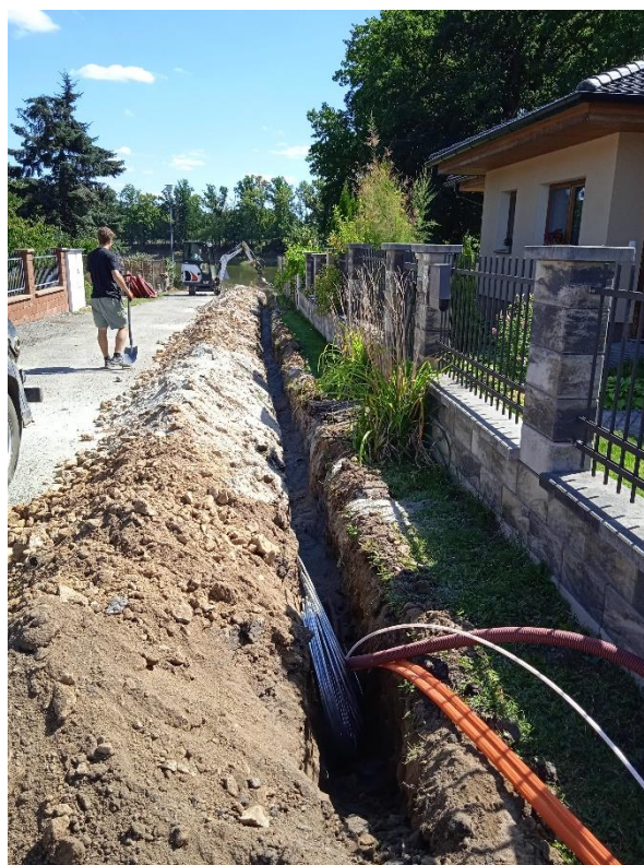
Výstavba veřejného osvětlení na Hůrkách (archiv města)
