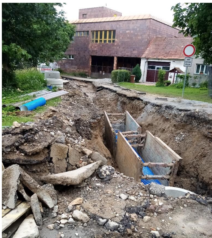
Rekonstrukce kanalizace v ulici Husova a výměna veřejného osvětlení v ulici Míru. (foto: MěÚ)
