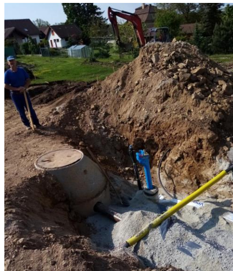
Oprava a zateplení domu č.p. 703 a realizace ZTV na Hůrkách (foto: M. Mrázek)
