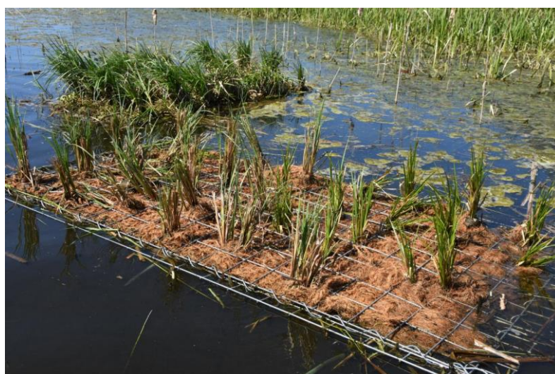
Instalace umělého plovoucího ostrova (foto: FŽP ČZU Praha)
