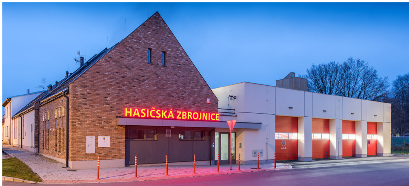
Zrekonstruovaná Husova ulice, dětské hřiště za kulturním domem a nová hasičská zbrojnice. (archiv Města)
