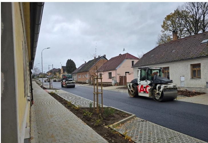
Husova ulice v době výstavby v roce 2024 – dokončovací práce. (archiv autora)
