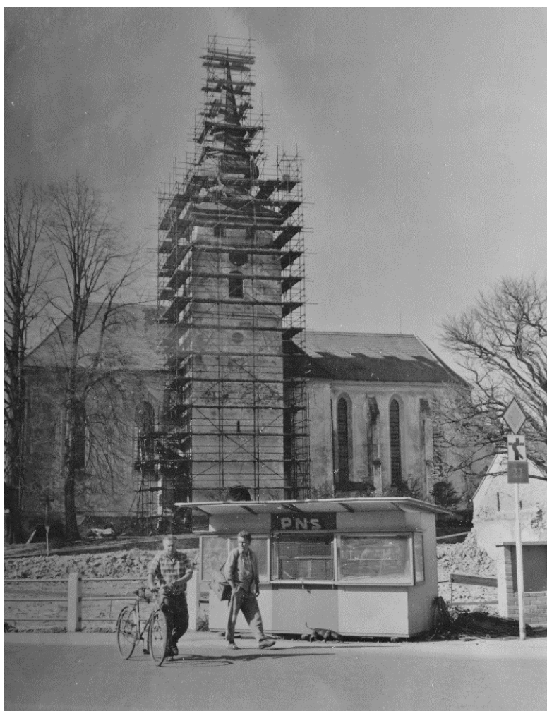
Rekonstrukce věže řečického kostela v roce 1980 (zdroj: archiv Města Kardašova Řečice)
