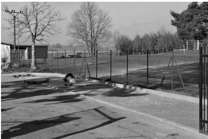
Výstavba nového parkoviště v mateřské škole (foto: N. Semerád)
