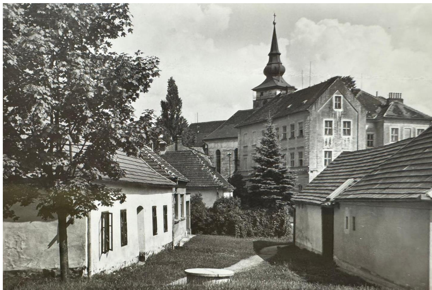
Pohled z ulice Tyršovy (dříve Růžová nebo Horní) na budovu základní školy a kostel na fotografii B. Procházky z druhé poloviny 20. století. (archiv A. Chvojkové)
